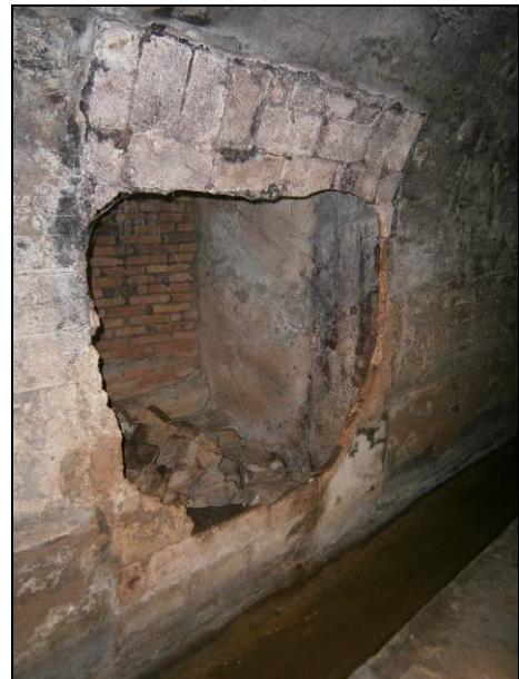
FOTO 20 – Accés amb un doble tapiat, el primer d'ells parcialment rebenat. Correspon a l'accés de llevant del carrer Juan de Sada per sota Violant d'Hongria
