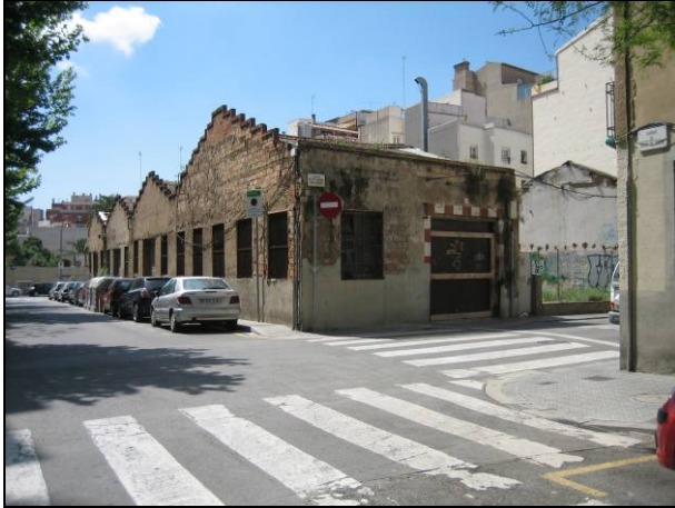
FOTO 01 – Cantonada del carrer Juan de Sada amb Violant d'Hongria on s'efectuà la cala de comprovació
