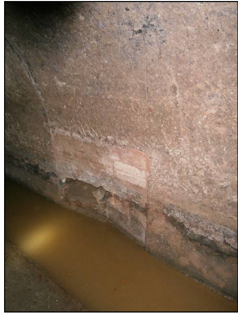
FOTO 30 Petita obertura tapiada al costat de llevant del tram que discorre sota el carrer de Juan de Sada, prop de Roger
