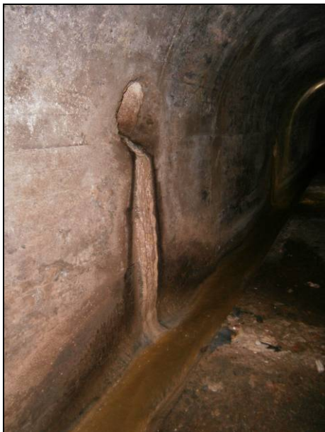
FOTO 15 – Desguàs procedent d'una de les finques del carrer de Juan de Sada. Són l'origen de la majoria de matèria orgànica que s'hi troba
