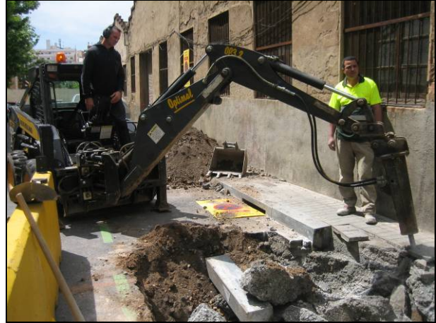
FOTO 02 – Inici de la cala de comprovació
