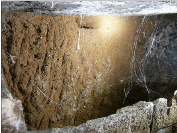
FOTO 19 – Detall de l'obertura anterior. Podem apreciar-hi els cops de pic en el substrat geològic
