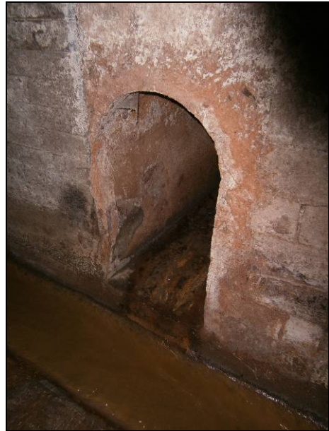
FOTO 14 – Un dels embornals que desguassen al refugi. Tots presenten les mateixes característiques amb uns 55 cm d'amplada
