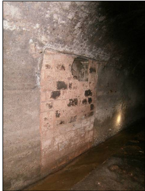
FOTO 10 – Accés original tapiat al costat de llevant, sota l'avinguda de Madrid
