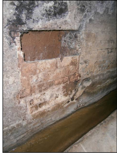
FOTO 18 – Obertura tapiada i oberta parcialment posteriorment d'una galeria o accés que només es va iniciar
