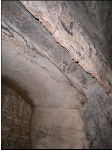
FOTO 21 – Detall de la volta i una paret lateral de l'accés de la foto anterior
