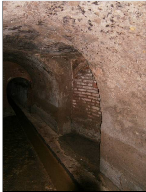
FOTO 26 – Accés original al carrer de Roger. Al fons, la claveguera del mateix carrer continua en direcció oest
